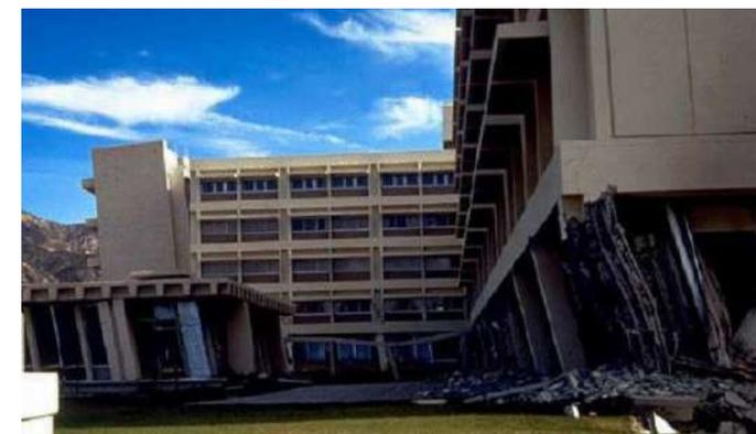
Meccanismi per piano debole negli edifici in c.a. soggetti ad azioni sismiche
